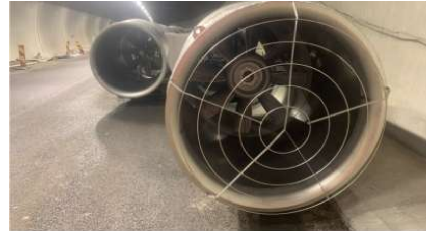
33 slike ventilatorer (vifter) skal inn i de to tunnelene på ny E16 mellom Hole og Bærum. (Foto: Hjel West)
