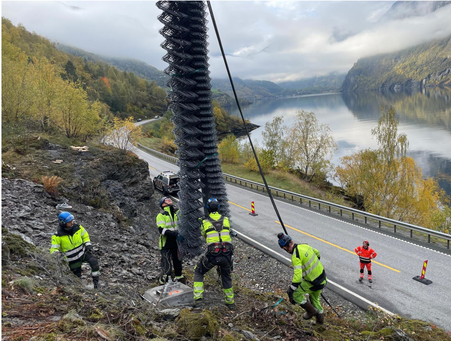
Montering av skrednett, Aurland 7. oktober 2024
