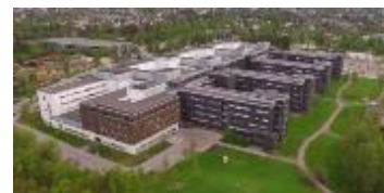
Akershus universitetssykehus HF Kreft- og somatikkbygg
