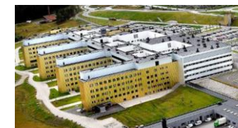
Sykehuset Østfold HF - Stråle- og somatikkbygg
