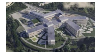
Oslo universitetssykehus HF Ny sikkerhetspsykiatri
