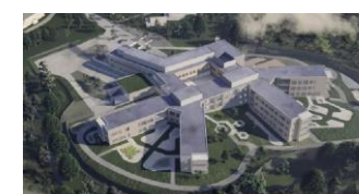
Oslo universitetssykehus HF Ny sikkerhetspsykiatri
