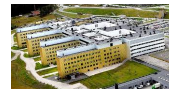
Sykehuset Østfold HF - Stråle- og somatikkbygg
