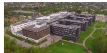
Akershus universitetssykehus HF Kreft- og somatikkbygg
