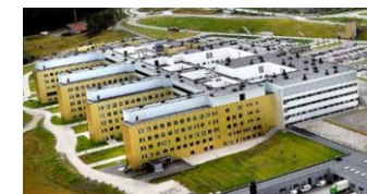
Sykehuset Østfold HF - Stråle- og somatikkbygg
