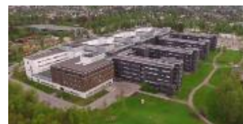
Akershus universitetssykehus HF Kreft- og somatikkbygg
