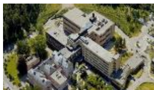
Sykehuset Telemark HF Utbygging somatikk Skien
