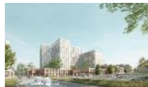
Oslo universitetssykehus HF Nye Aker
